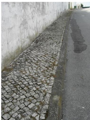
Figura 27 - Passeio em calçada, com herbáceas, derivado a falta de manutenção
