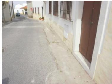
Figura 47 - Transição entre os materiais do pavimento da valeta e arruamento executada sem cuidado
