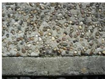
Figura 24 - Seixo rolado misturado com argamassa de cimento
