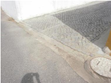
Figura 46 - Transição de materiais dos arruamentos executada sem cuidado
