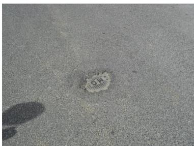
Figura 38 - Repavimentação do asfalto do arruamento com a simulação da tampa da caixa da infraestrutura – Rua Carlos Relvas
