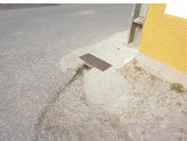
Figura 39 - Sistema de escoamento de águas pluviais deficiente – Rua da palmeira
