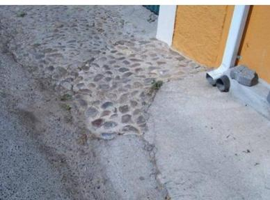
Figura 40 - Sistema de escoamento de águas pluviais deficiente – Rua da Roda
