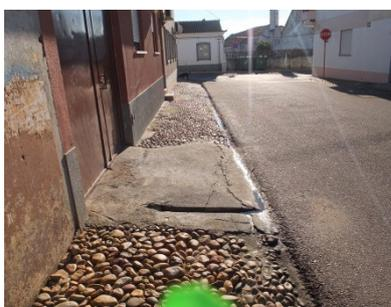
Figura 13 – Pavimentos em desadequados e em mau estado.
